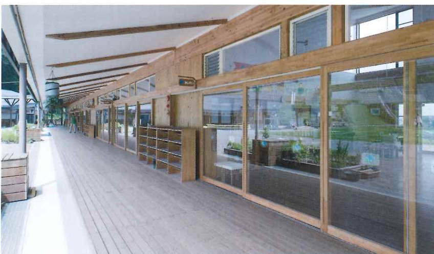
縁側。保育室同士の行き来は室内でも可能。左の円筒は柱のように見えるが、屋根に降った雨水を貯める配管である。庇は特殊な超高剛性の梁で片持ちの構造
