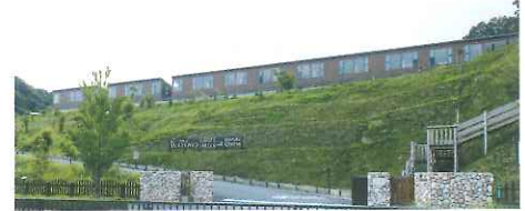
正門前から。17mの高さを上げるスロープがつくられている
